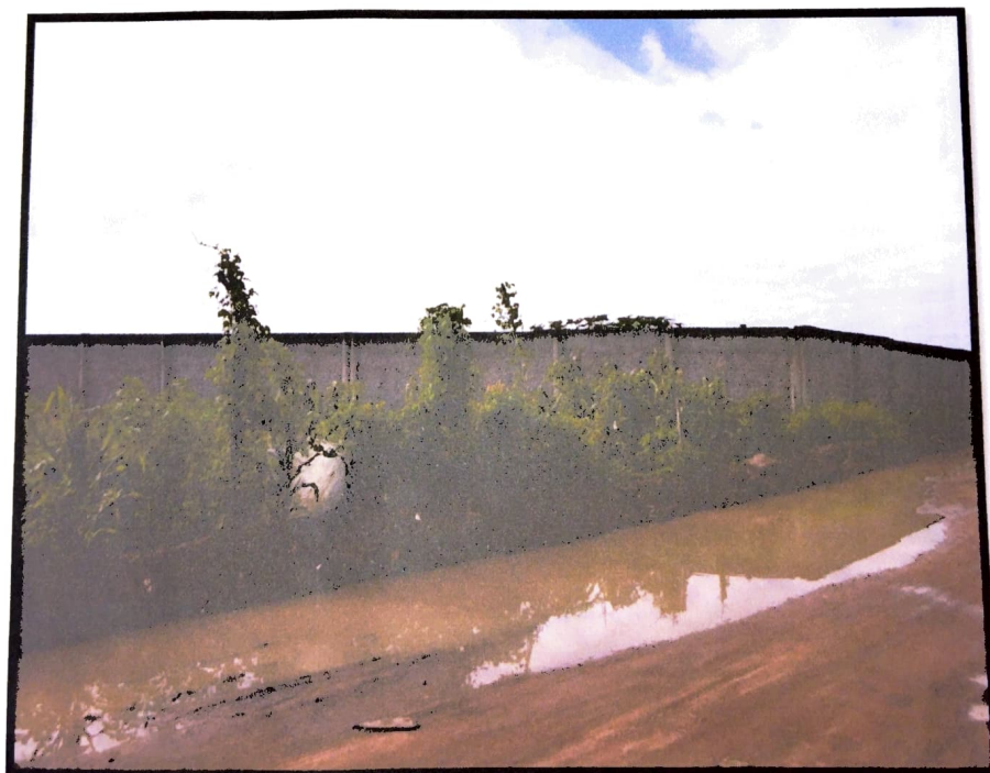
Frete do Terreno Estrada de Acesso a Rod AL 220
